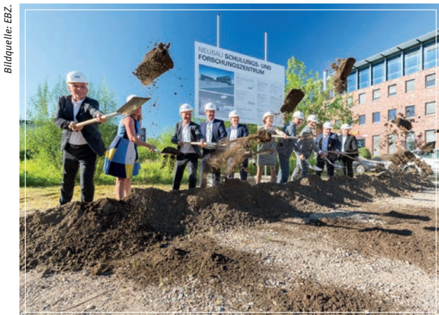
Hochkarätige Akteure setzen den Spatenstich zum EBZ-Neubau.
